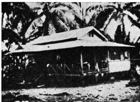
2. 第三型家屋 見るからにいかにも住み心地のよさそうな島民の文化住宅である。土台柱にはセメントを使用している。
