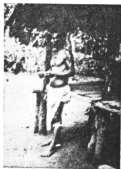
3. 第二型家屋の柱 柱として木性羊歯の幹を掘立てている。
